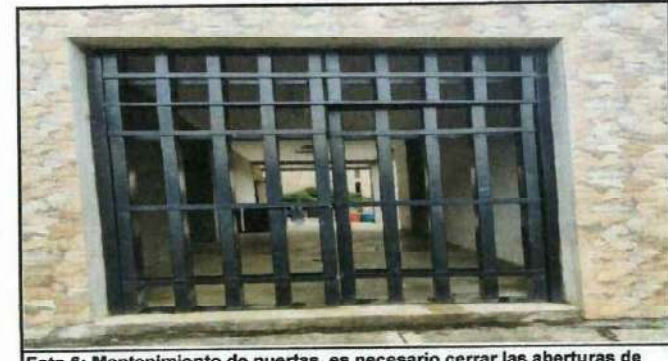
Foto 6: Mantenimiento de puertas, es necesario cerrar las aberturas de las puertas para evitar la entrada de perros en el instituto.
